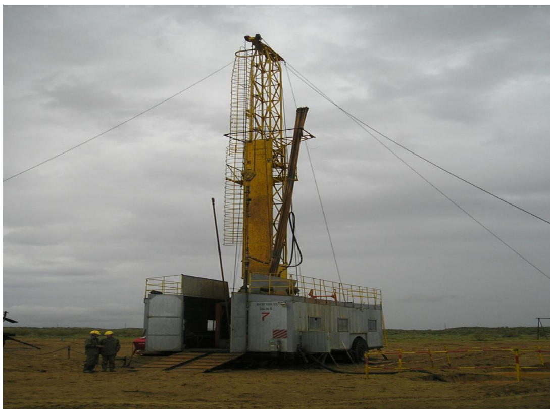
Рисунок 3 - Буровая установка ЗИФ-1200
